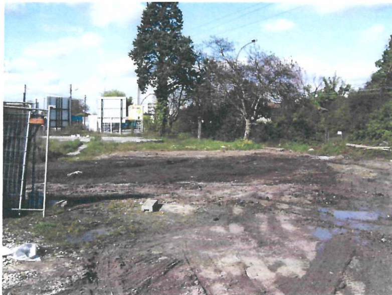
Figure n°4 : Vue de la zone de stockage après enlèvement des terres.
