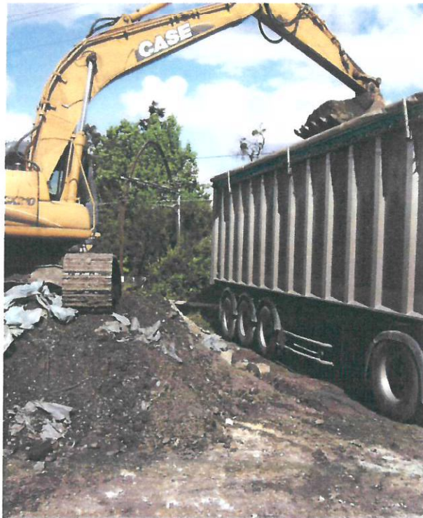
Figure n°3 : Chargement des terres polluées.
